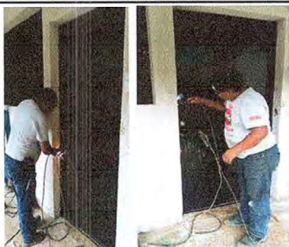
Foto 3: Mejoramiento de puertas de lámina por puertas por puertas prensadas de metal con su respectiva chapa.
