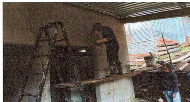
Foto 8: Mejoramiento pared de lámina y malla por Block para dos aulas.
