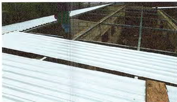
Foto 1: Sustitución de lámina acanalada en mal estado por lámina troquelada Aluzinc calibre 26
