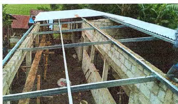
Foto 2: Sustitución de soporte de madera por estructura de metal (costaneras)
